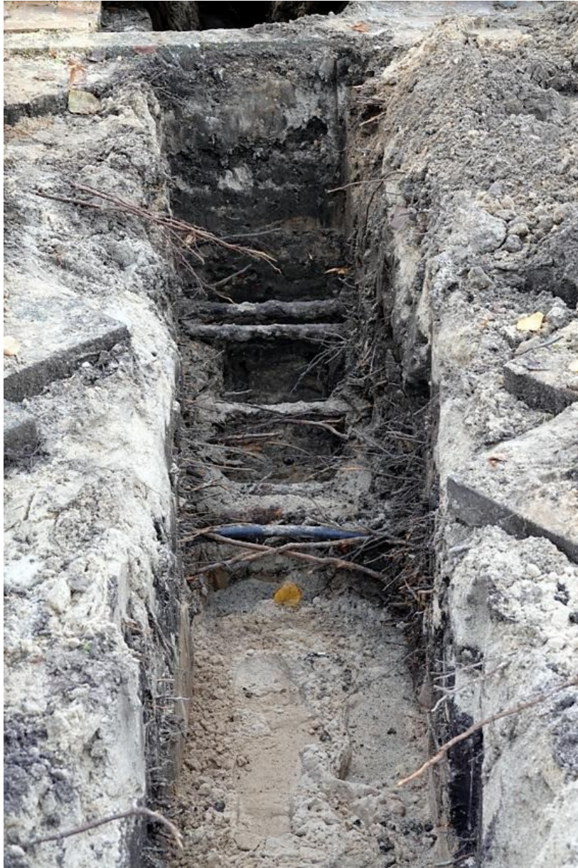
Beispiel: Suchschachtung in der Breiten Straße vor Hausnummer 11 Foto: Celler Klimaplattform, 19. November 2022
